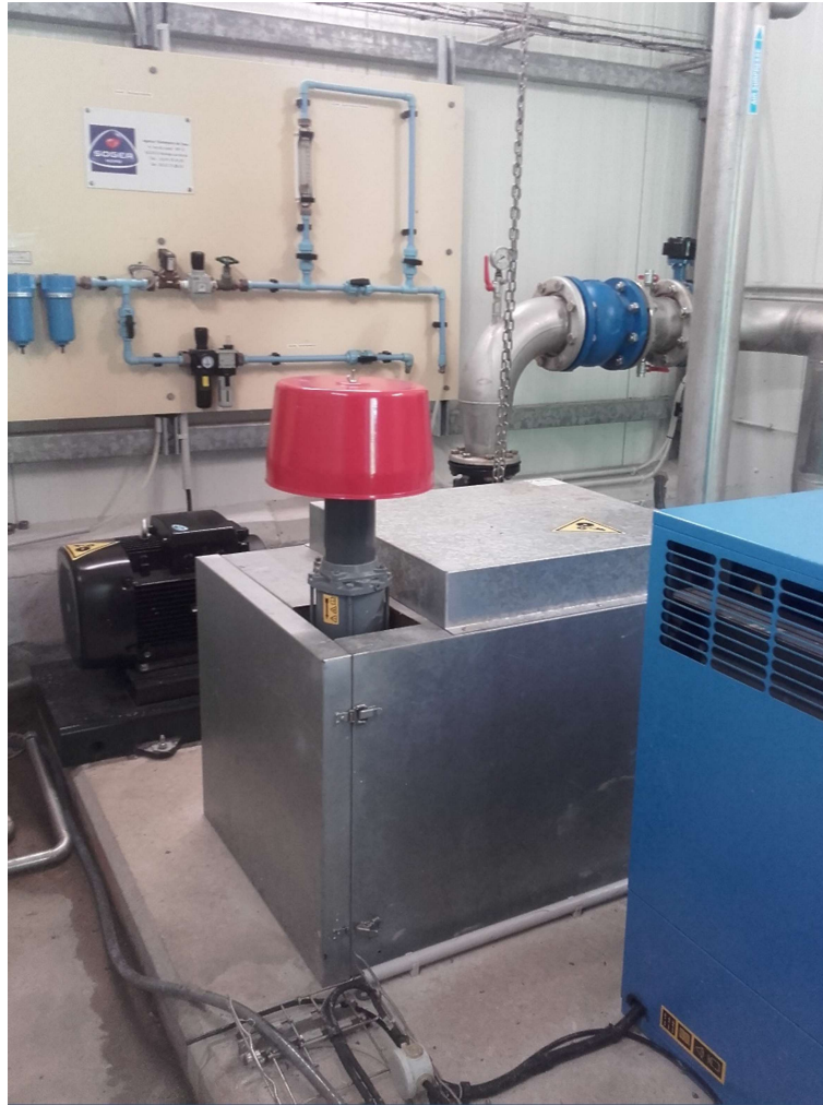
Figure 10 : Purgeur d'air automatique
