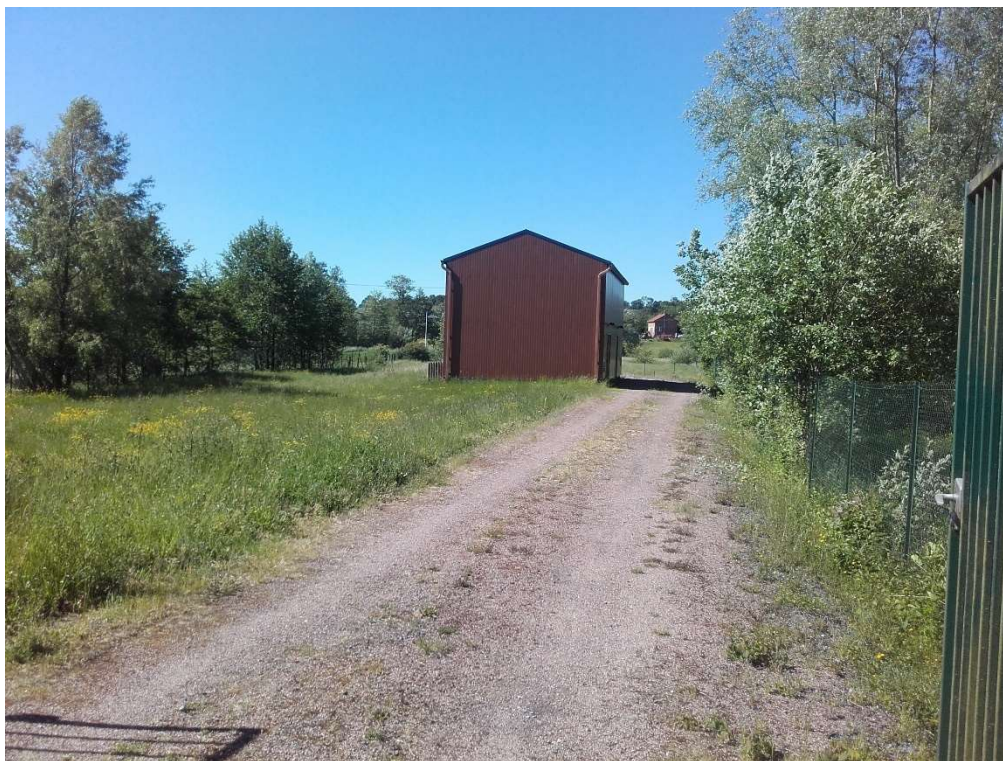
Figure 2: Local et voie d'accès à la station de traitement
