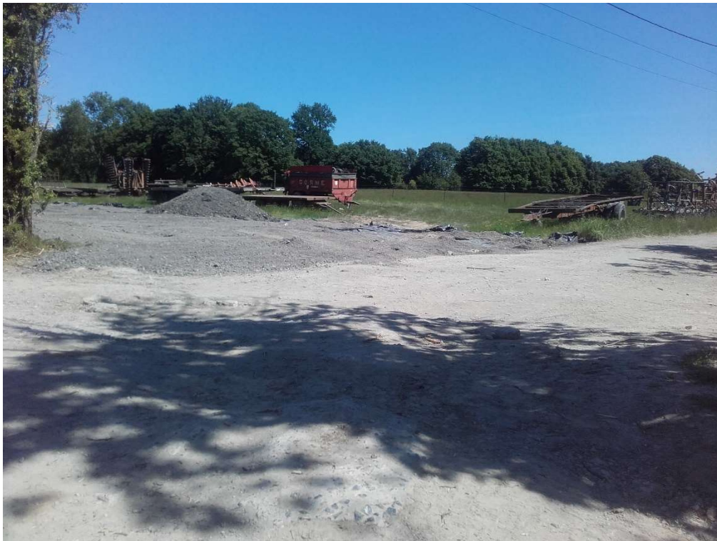
Figure 20 : Environnement - Dépôt de matériaux
