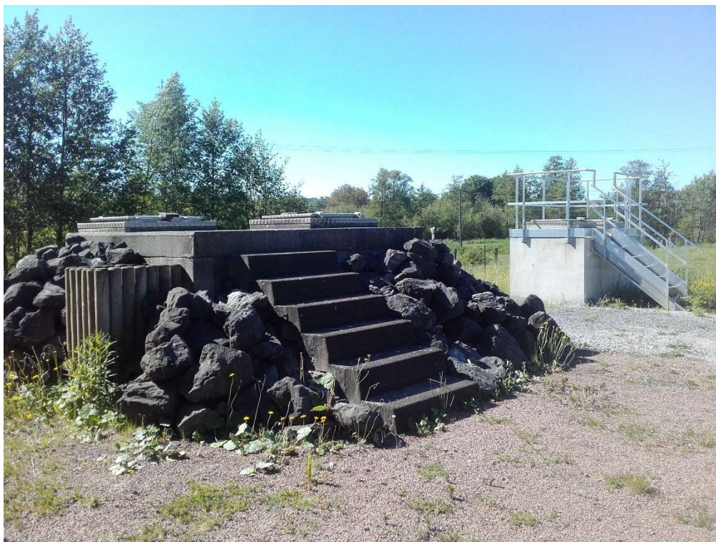
Figure 3 : forage AEP (gauche) forage de reconnaissance (droite)
